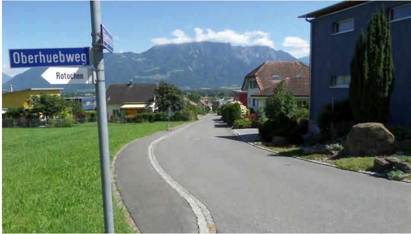
Abb. 13: Überbreite Fahrbahn an der Stegstrasse
