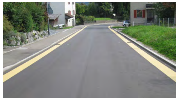
Abb. 27: Wirkung langer seitlicher Farbbänder (Beispiel Engelburg)
